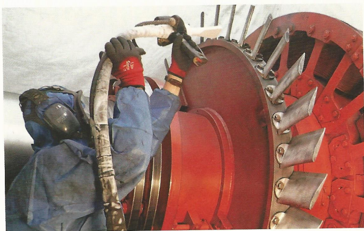
Egger PowAir Cleaning im Einsatz
